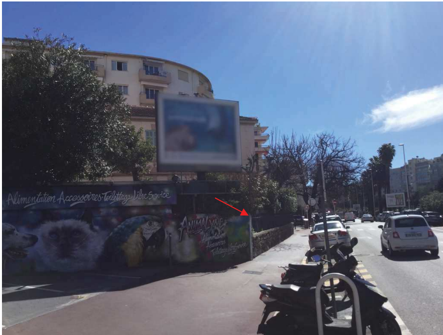
Publicité apposée à moins de la moitié de sa hauteur d'une limite séparative de propriété, Cannes, Mars 2018
