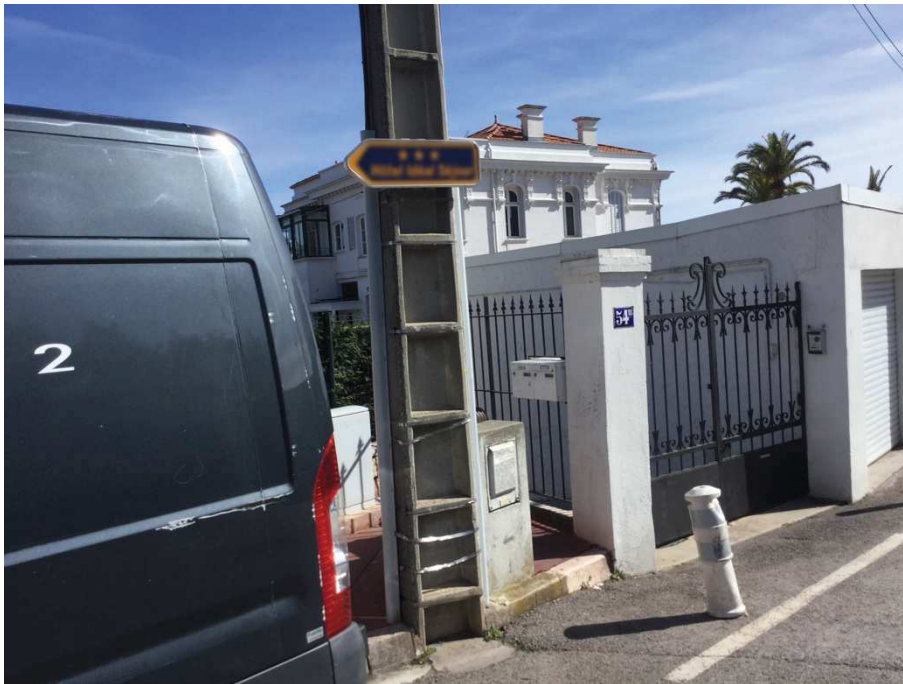
Publicité sur un poteau de distribution électrique, Cannes, Mars 2018
