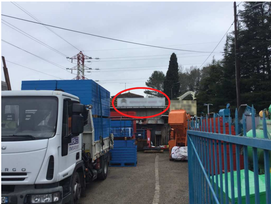
Publicité non-lumineuse interdite sur toiture ou terrasse en tenant lieu, Cannes, Mars 2018
