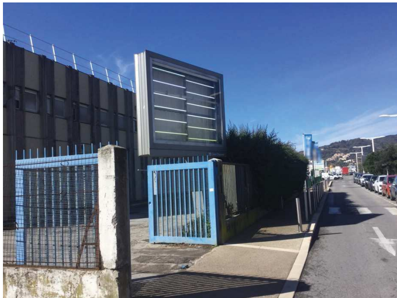
Publicité en mauvais état d'entretien et de fonctionnement, Cannes, Mars 2018
